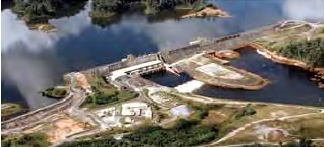
Vue aérienne du barrage de Petit-Saut
